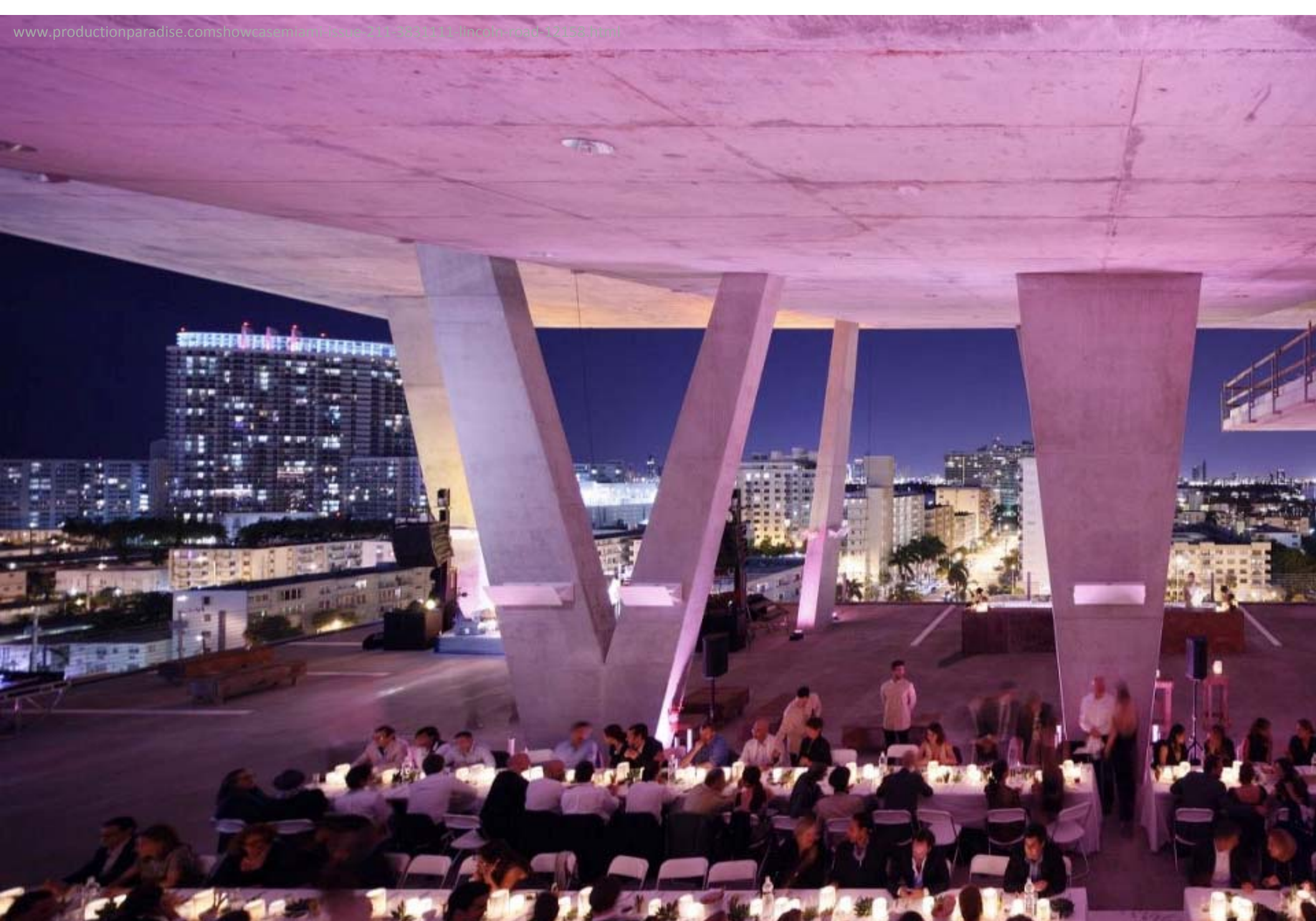
1111 Lincoln Road / Herzog & de Meuron
