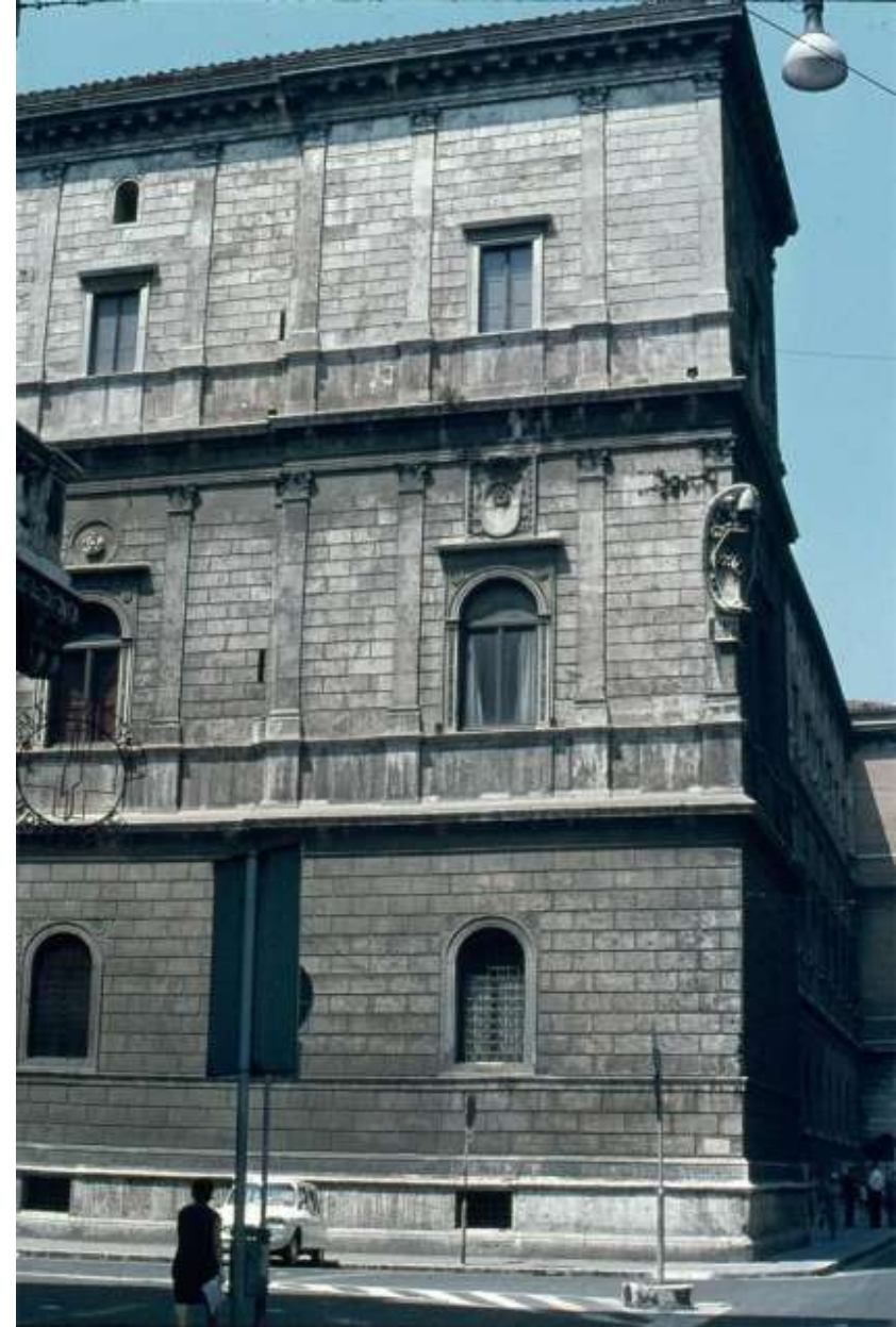
Palazzo della Cancelleria Brunelleschi, 1483-1513
