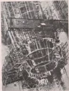
Das Entstehen einer Eisenkonstruktion.
